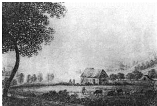
Alter Schacht / oberhalb des Schulneubaus 1780 bis 1839 Tiefe 125,00 m
